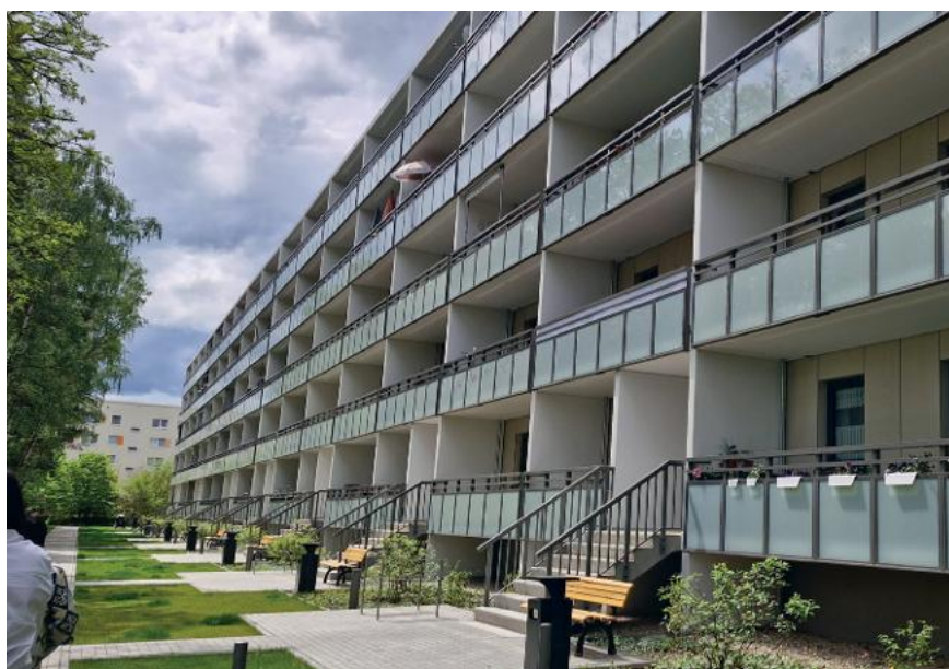
Das Modernisierungsprojekt eines Wohnhauses in Ludwigsfelde – serielle Modernisierung (Energiesprung)
